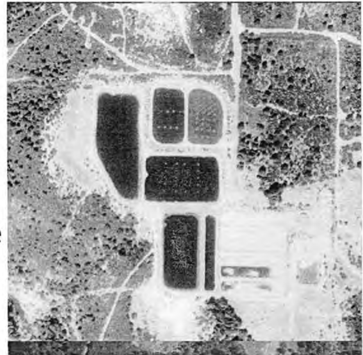
Mt. Shasta WWTP - 1994
